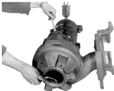
Рис. 14 Измерение зазора в щелевом уплотнении
